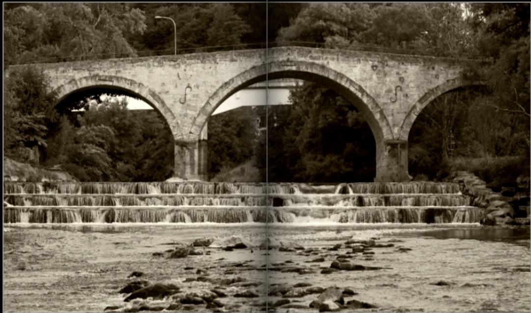
Die Tössbrücke «Römerbrücke» verbindet das Dorf Rorbas und Freienstein. Diese denkmalgeschützte Steinbogenbrücke (Bj. 1806-08) wurde aus Kalktuffstein gebaut. Im Hintergrund die neue Tössbrücke (Bj. 1934-36).
